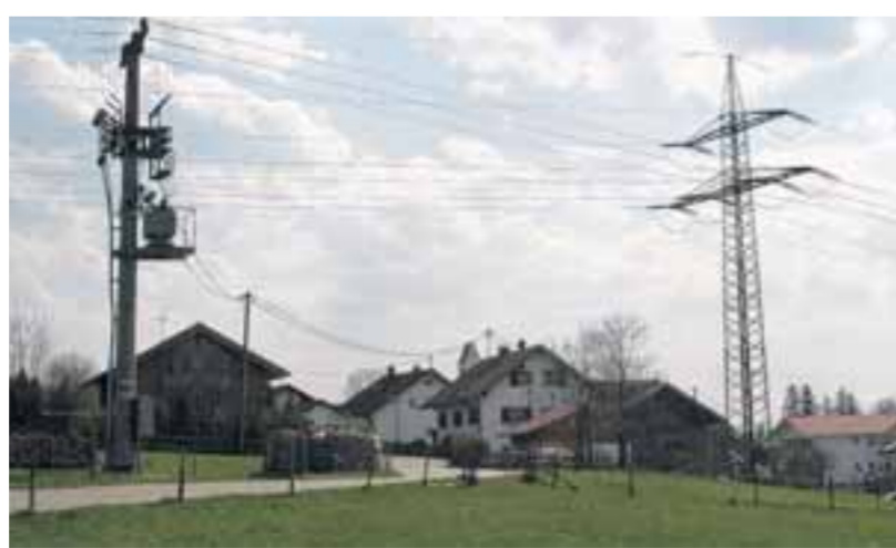
Von der Gemeinde wie vom Landkreis wird ein Erdkabel im nördlichen Bereich von Bernbach favorisiert. Die LEW wollen dort neue Stromleitungen verlegen. Zumindest sollen die Masten aber weiter von der Wohnbebauung weg stehen, heißt es in der Stellungnahme der Kommune. Foto: Andreas Filke
